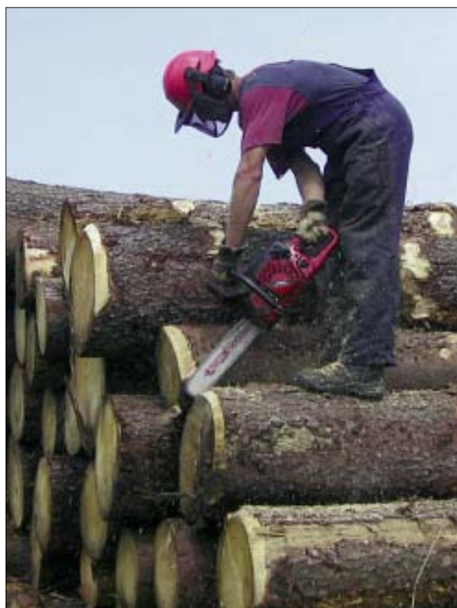
Abbildung 2: Entfernen von scharf- kantigen Blochteilen an der Oberseite des Ganter zum Schutz der Plastikfolie
