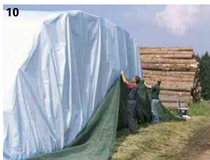
Aufbau des Folienlagers: 7 Aufbringung der Abdeckfolie, 8+9 Verschweißen der Abdeckfolie, 10 Anbringung der Windschutzgitter, 11 Luftabsaugung, 12 Am Ende der Luftabsaugung
