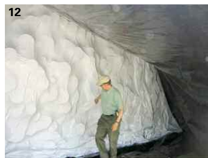
Aufbau des Folienlagers: 7 Aufbringung der Abdeckfolie, 8+9 Verschweißen der Abdeckfolie, 10 Anbringung der Windschutzgitter, 11 Luftabsaugung, 12 Am Ende der Luftabsaugung
